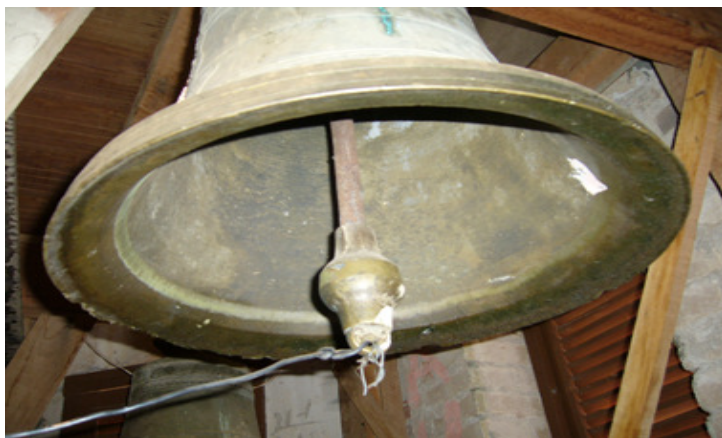
Foto 11 (19/02/2008) Vista inferior da boca do sino SOL, mostrando seu badalo e o fio metálico utilizado para acioná-lo. Autoria: Daniel Quintão
