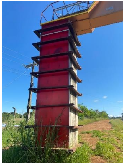
Figura 03 - Fonte: Arquivo pessoal da Contratada – Situação atual do Pórtico
