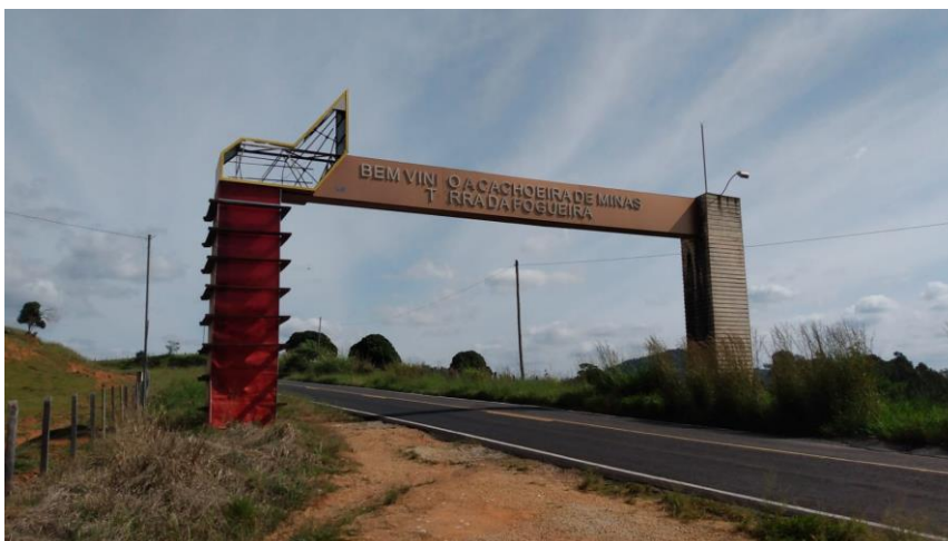
Figura 01 - Fonte: Arquivo pessoal da Contratada – Situação atual do Pórtico
