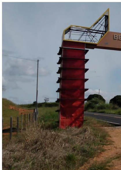
Figura 06 - Fonte: Arquivo pessoal da Contratada – Situação atual do Pórtico
