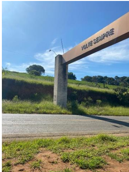
Figura 02 - Fonte: Arquivo pessoal da Contratada – Situação atual do Pórtico
