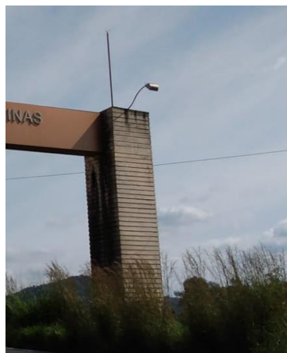
Figura 04 - Fonte: Arquivo pessoal da Contratada – Situação atual do Pórtico
