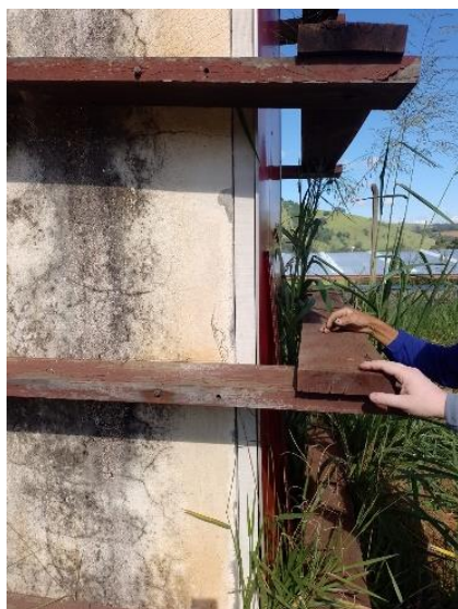
Figura 05 - Fonte: Arquivo pessoal da Contratada – Situação atual do Pórtico
