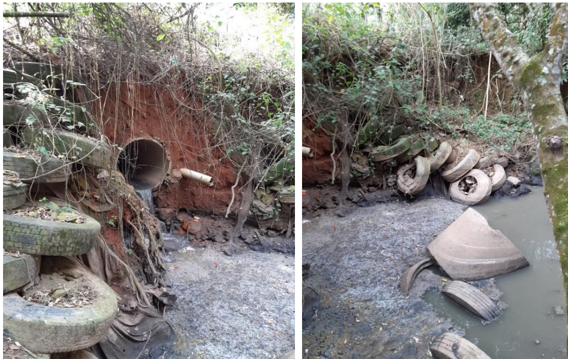
Figura 4.9 - Lançamento de águas pluviais e esgoto sanitário próximo ao lugar do evento de enchente
